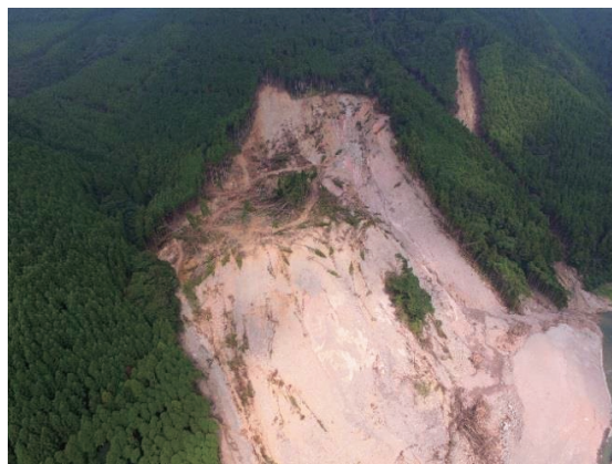
平成 29 年 7 月九州北部豪雨により発生した大分県日田市小野地区の大規模崩壊を対象としたドローンによる空撮写真
